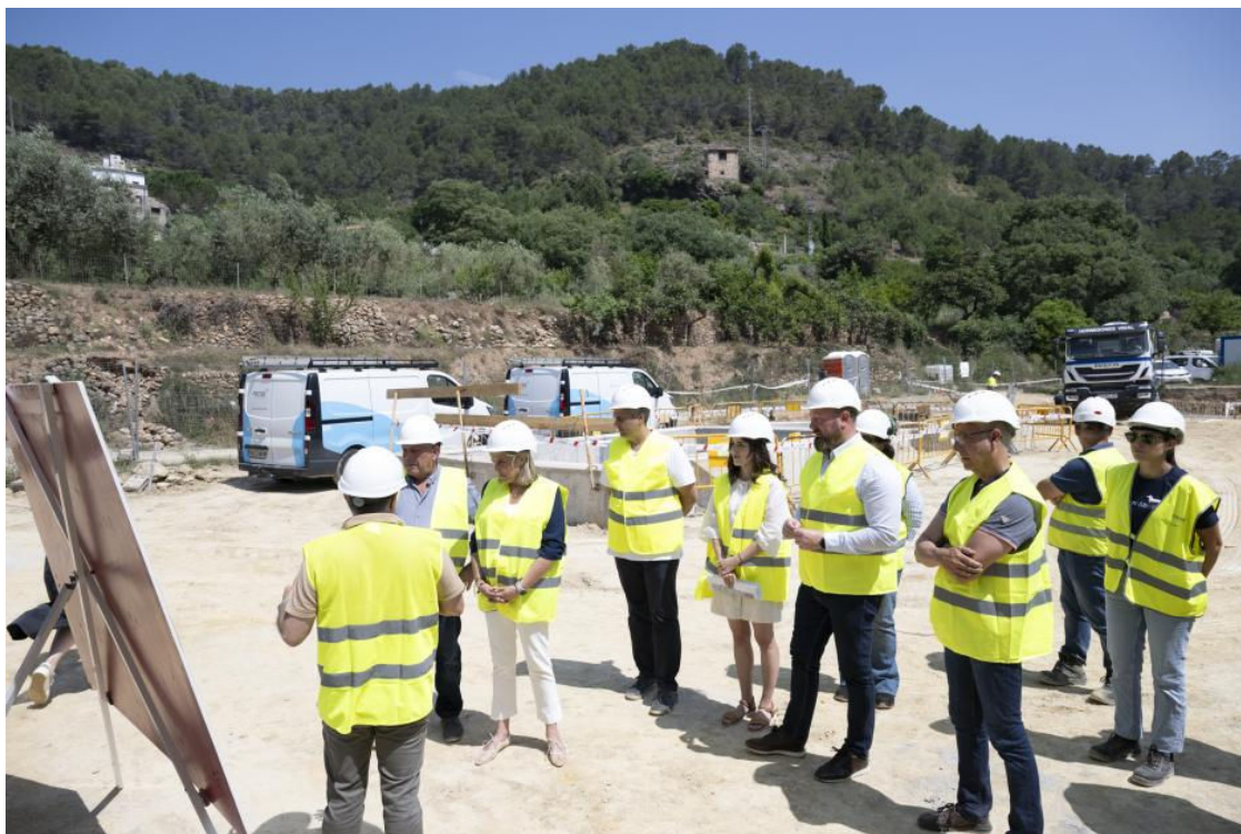
Visita de Marta Barrachina, presidenta de la Diputación de Castellón, a la Depuradora Alcudia Veo
